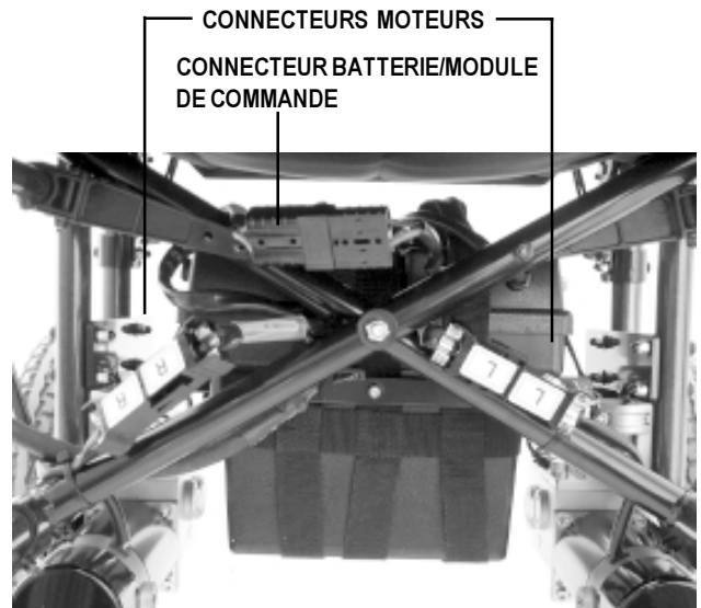
Figure 12. Branchements électriques avant
