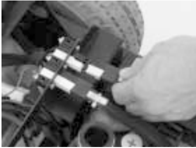
Figure 15. Connecteurs des batteries
